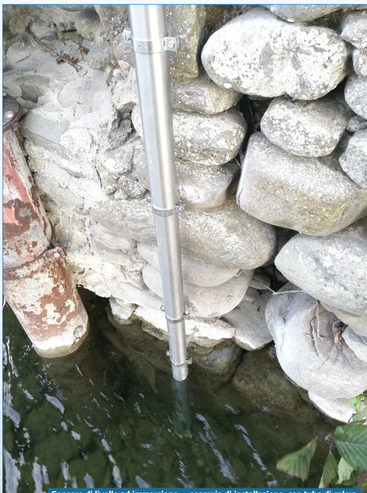
Sensore di livello ad immersione — esempio di installazione con tubo di calata
